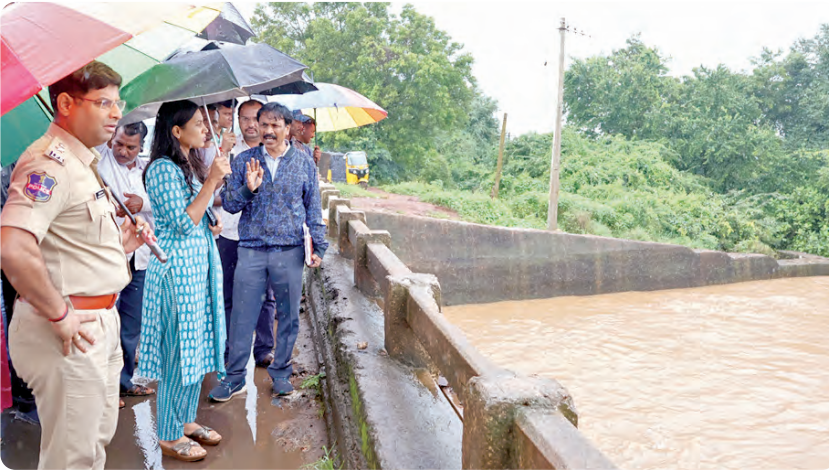
నారింజ ప్రాజెక్టును ఎన్పిఐతో కలిసి పరిశీలిస్తున్న కలెక్టర్ ప్రావీణ్య
